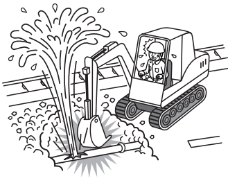
工事場内でガス管の埋設工事中、バックホーの操作をあまり、地中の水道管を破損してしまった。
